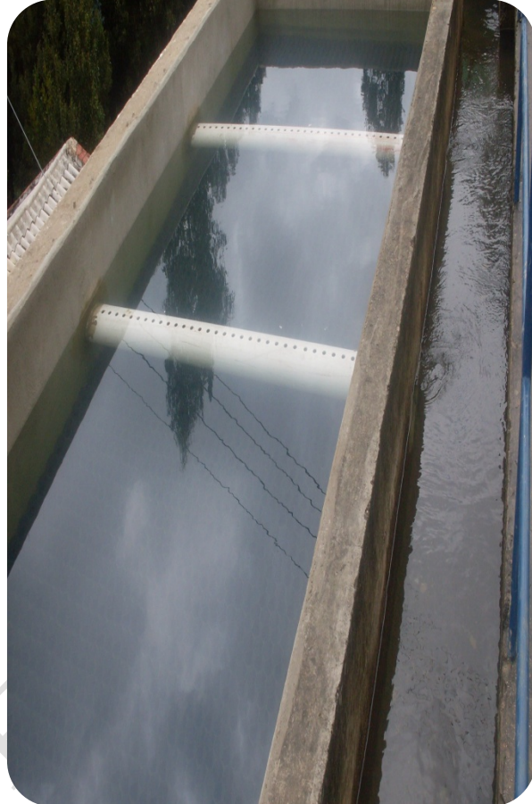
DESPUES CON MODULOS DE SEDIMENTACION
